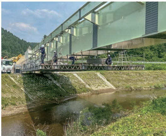
システム吊足場 国道7号(仮称)種梅入口交差点Aランプ橋
