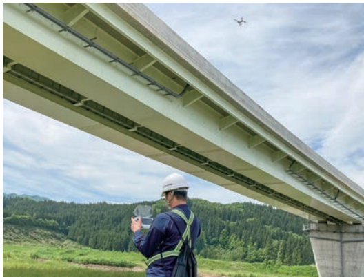
ドローンをを用いた橋梁点検 国道13号 役内川橋
