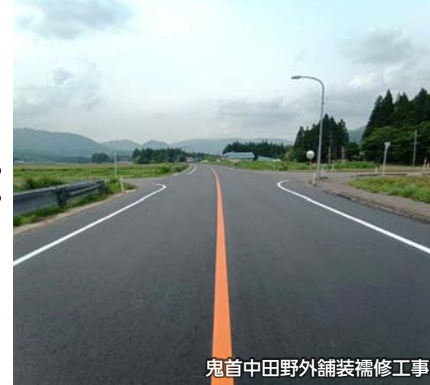
鬼首中田野外舗装補修工事
