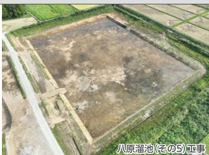
八原溜池(その5)工事
