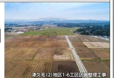
津久毛(2)地区1-6工区区画整理工事
