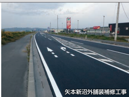
矢本新沼外舗装補修工事
