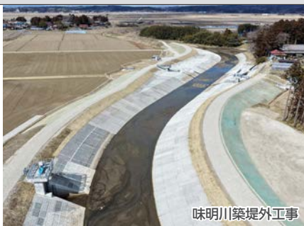
味明川築堤外工事
