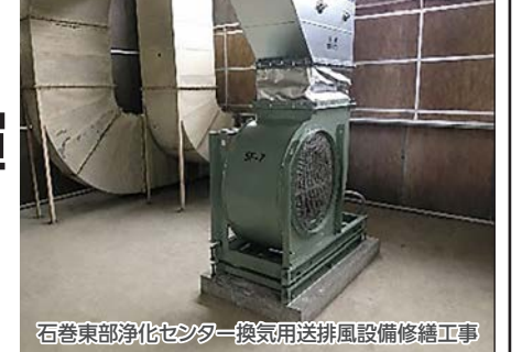
石巻東部浄化センター換気用送排風機設備修繕工事
