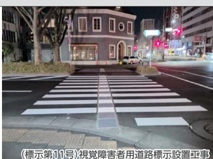
(標第11号)視覚障害者用道路標示設置工事
