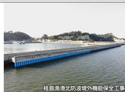
桂島漁港北防波堤外機能保全工事
