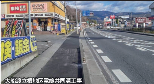
大船渡立根地区電線共同溝工事
