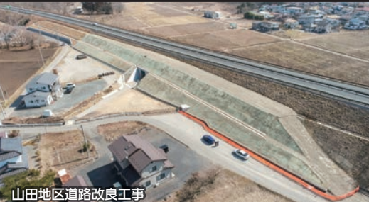
山田地区道路改良工事
