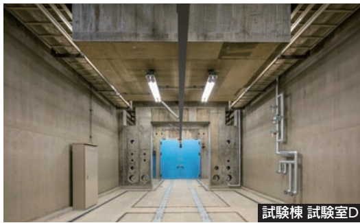
試験棟 試験室D
